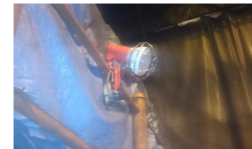
カムワルツ山側にある手摺りに照明設置
