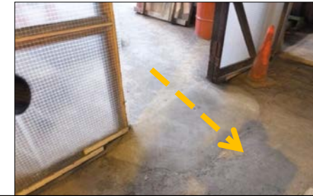
傾斜大きいため材料落下の危険
